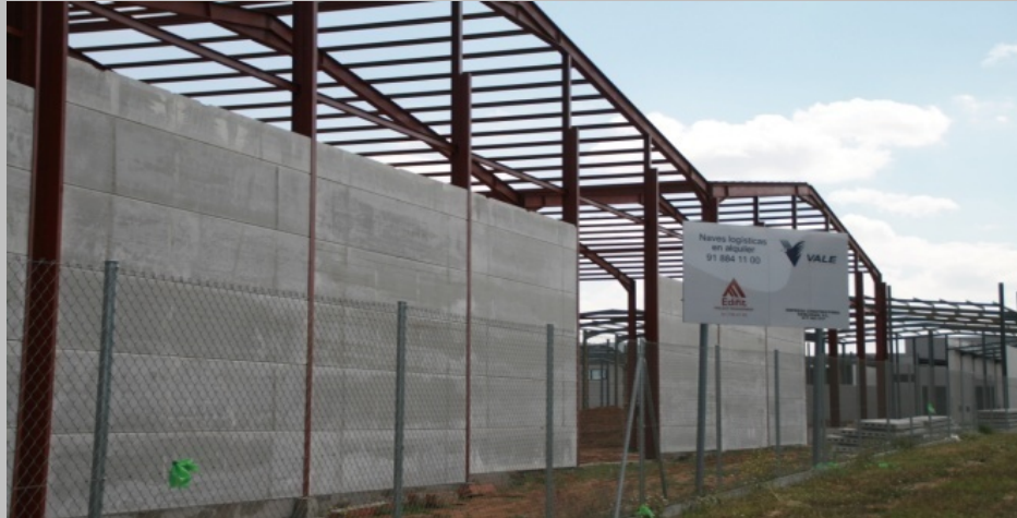
ESTADO ACTUAL DE LA PARCELA.
