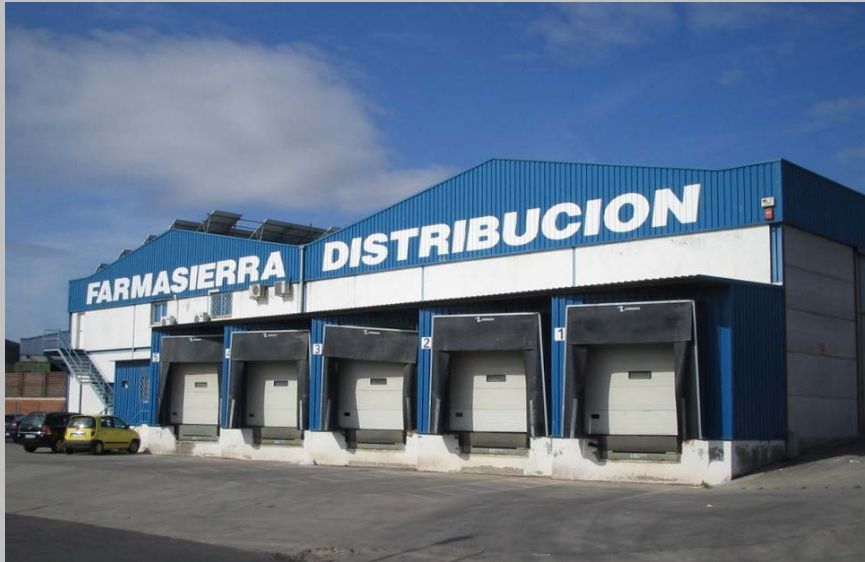
IMAGEN DE LA FACHADA DE LA NAVE
